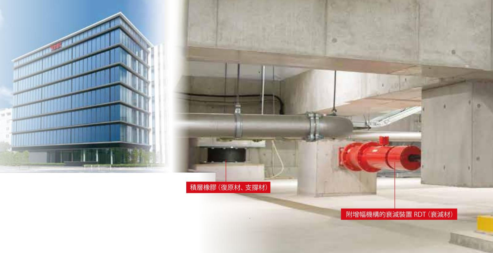
積層橡膠 (復原材、支撐材)
