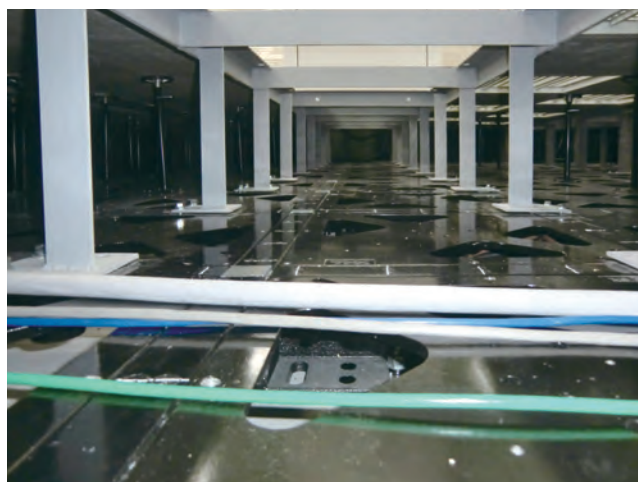
床下配線状況
