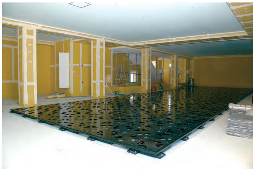
免震モジュールTGS型設置
